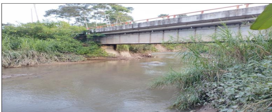
FIGURA N°02: SE OBSERVA QUE LOS BORDES QUE CERCANOS AL MURO DEL PUENTE VIENEN SIENDO EROSIONADOS, POR LO QUE SE CORRE EL RIESGO DEL COLAPSO DEL PUENTE.
